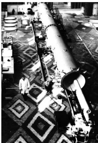
Рис. 2. Сборка во ВНИИЭФ первого мегаджоульного ВФД-лазера \Phi -1200 (а) и подготовка его к испытаниям на полигоне, Сары-Шаган, 1969 г. (б) [10, 11, 14]
