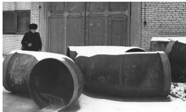
Рис. 6. Элементы газового контура импульсного мегаваттного лазера, 1989 г.
